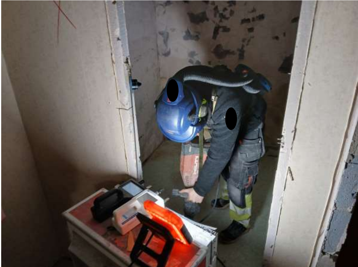
Bild 3. Arbete med bilning i badrum. Bild visar operatör i arbete där partikelräknare står på luftrenaren och den stationära provtagaren i dörröppningen kan ses.
