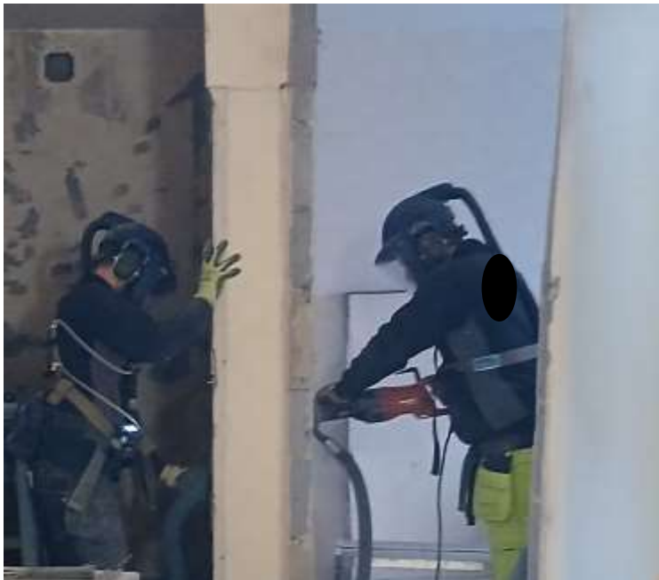
Bild 4. Arbete med demontering av lättbetongväggar i badrum. Bild visar operatörer i arbete där en använder tigersåg med utsug medan den andra står på andra sidan väggen med en dammsugare.
